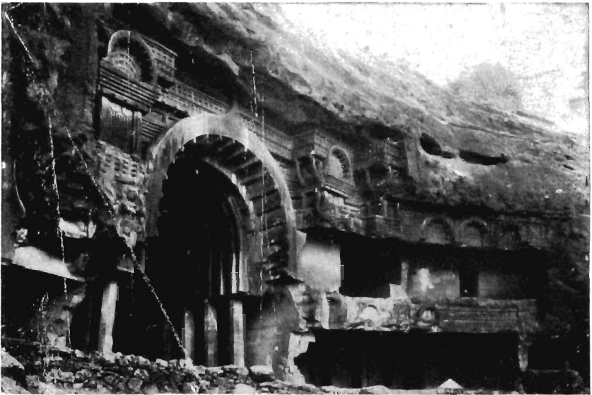
Fig. 14. Bhājā, Chaitya cave: Facade.
